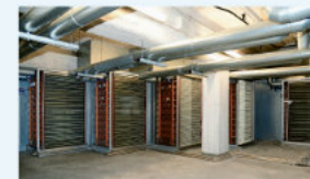
Die GSWT®-Technologie freistehend in großen Lüftungskanälen © SEW GmbH
